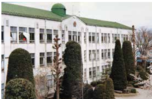
一棟改築前の校舎
